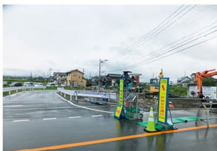
工事が進む村道稻荷八幡川線
