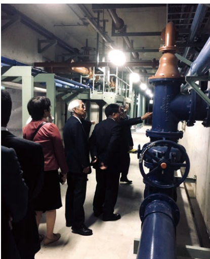
下水道施設の中心部を視察
