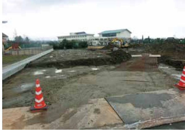
造成が進む子育て賃貸住宅
