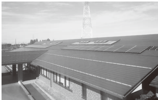
太陽光パネル
