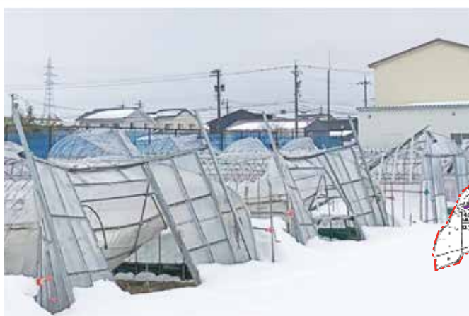
雪に埋もれて倒壊したビニールハウス
