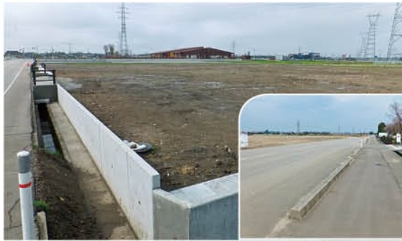
スポーツグラウンド建設予定地 前面道路
