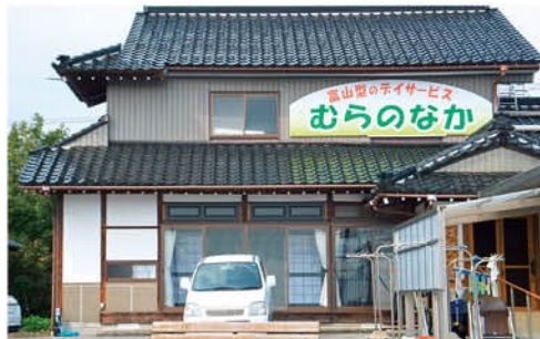
空き家を活用したデイサービス施設
