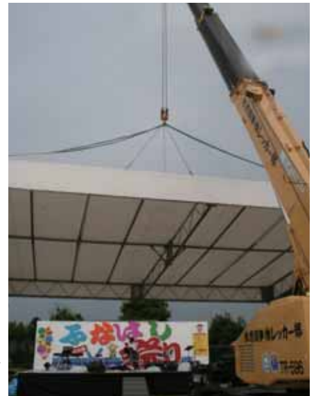
レッカー車によるステージ屋根設営の様子
