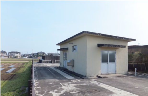
水道の安定供給のため、配水設備が導入される 第一水源地（東芦原）
