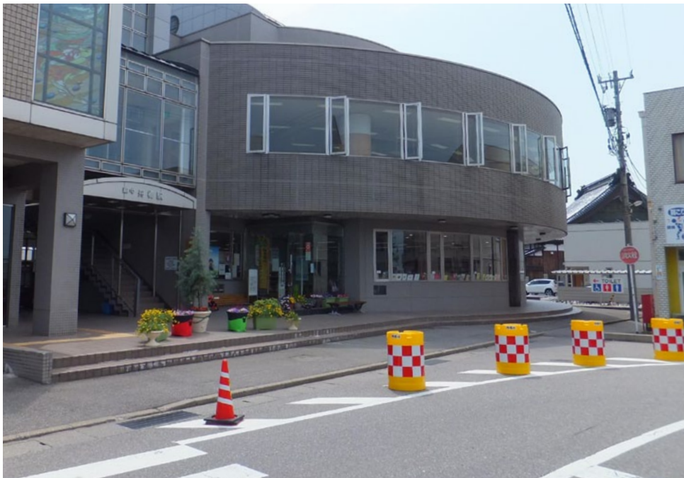
▲駅前道路には駐停車禁止を示す黄色のセフティドラム等が設置されています。
